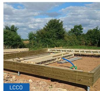
Plancher rez-de-chaussée sur pieux
